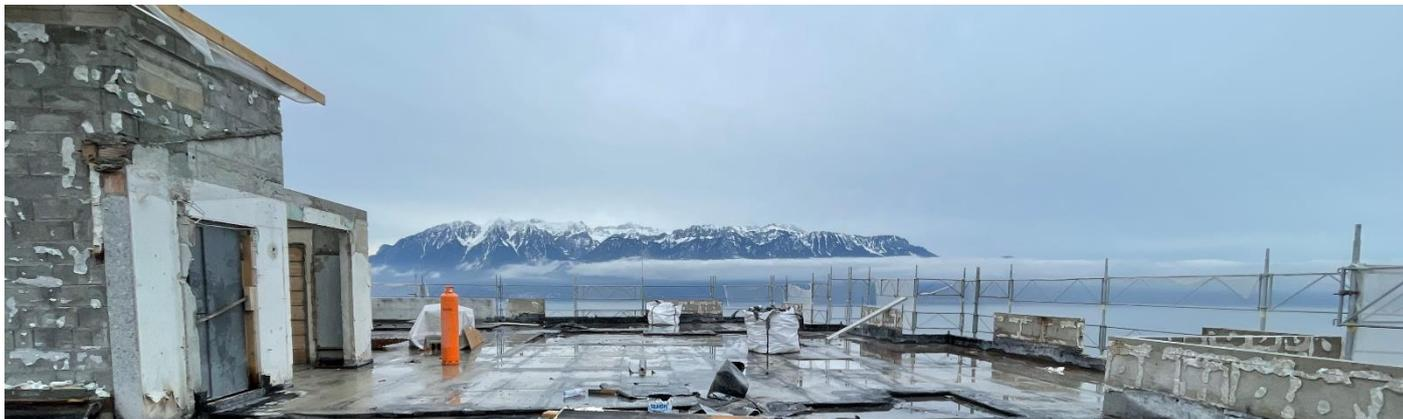
Le premier balcon, au niveau 5, a été coulé. Les balcons suivants aux niveaux 6, 7 et 8 seront exécutés d'ici au milieu du mois de février 2023. A chaque étage, des cornières métalliques sont fixées à la façade et des piliers sont posés pour reprendre le poids des balcons. Chaque balcon nécessite donc un travail de 10 à 14 jours.
