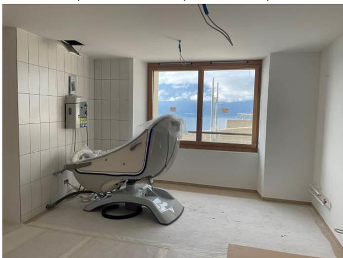
Aux niveaux 6 à 8, la fermeture des cloisons et la pose du carrelage dans les salles de bains continueront jusqu'en novembre.
