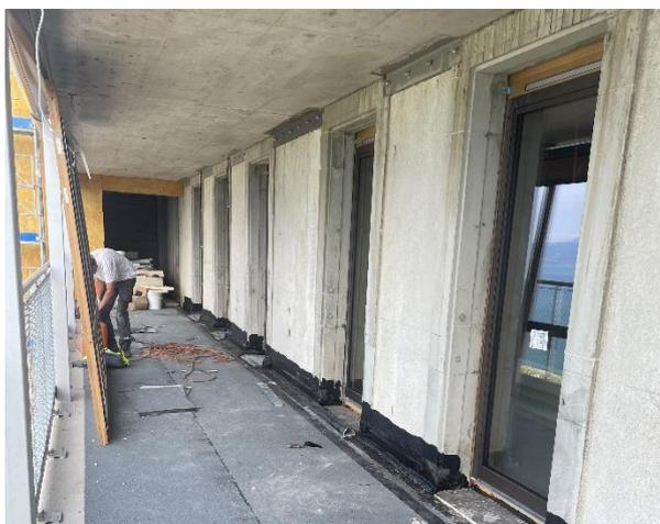
Toutes les fenêtres seront posées au début juillet. La pose de l'isolation périphérique crépie, des tablettes de fenêtres et des stores se fera en suivant. La première étape (toute la façade sud) devrait être finie fin juillet et les échafaudages démontés, si les délais de livraison sont tenus !
