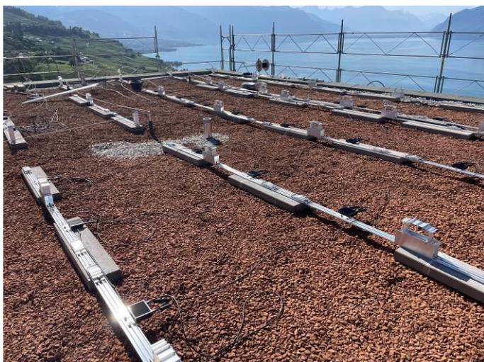
Le gravier a été posé. Il contient de la terre cuite pour favoriser l'ensemencement afin de végétaliser la toiture et améliorer le rafraîchissement derrière les panneaux solaires. Ces panneaux ainsi que les éléments techniques seront installés et mis en fonction fin août.
