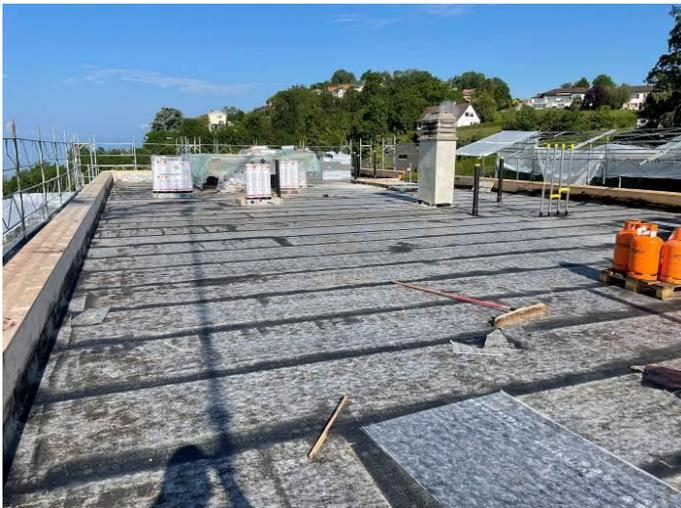
La pose des diverses couches d'étanchéité et d'isolation est en cours. En juin, les panneaux solaires et les monoblocs de ventilation seront posés.
