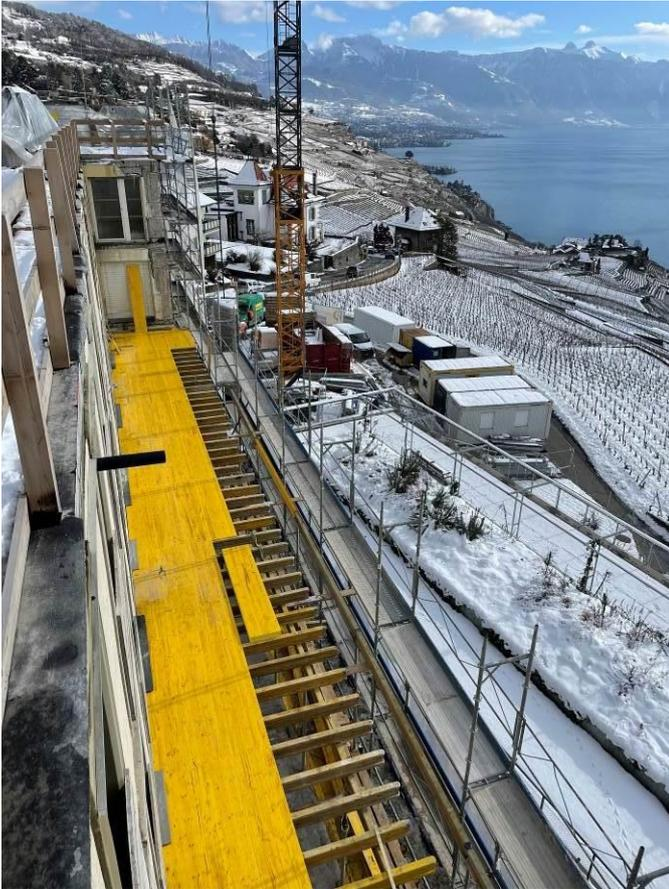
Le balcon du niveau 6 est en cours d'exécution (*image de gauche*). Ceux des niveaux 7 et 8 vont suivre et seront finis fin février. Les maçons continuent également à construire les acrotères du niveau 8 (*image ci-dessous*), les murs intérieurs et préparent les nouvelles ouvertures de fenêtres.
