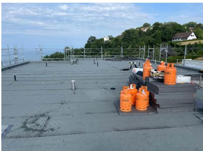
Au mois de juillet, la pose des équipements de toiture sera finalisée (monoblocs pour la ventilation, panneaux solaires pour l'eau chaude et l'électricité et divers). Le gravier sera soufflé sur les terrasses technique
